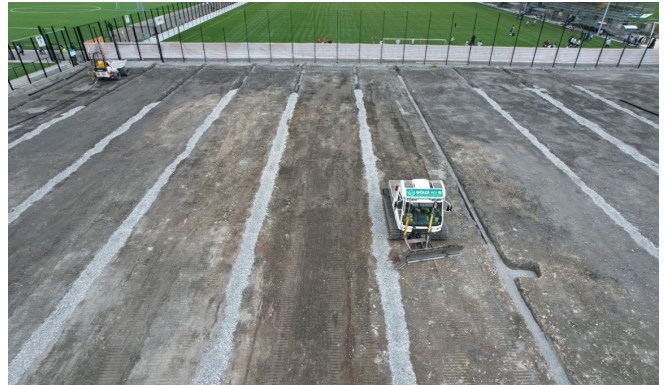
Bau Naturrasenplatz Nr.2
