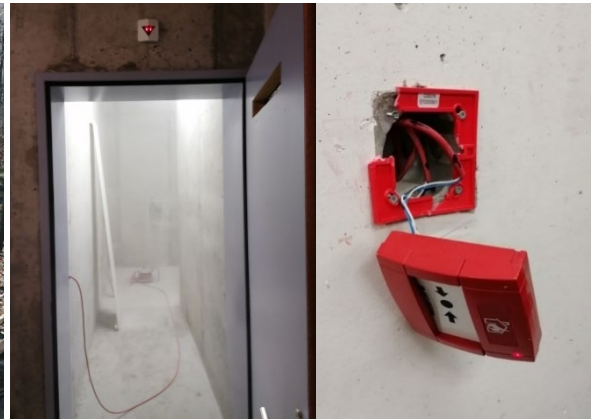
Auslösegründe für Brandmeldeanlagen: Staubeentwicklung bei Bauarbeiten / Mechanische Gewalteinwirkung auf Handtaster
