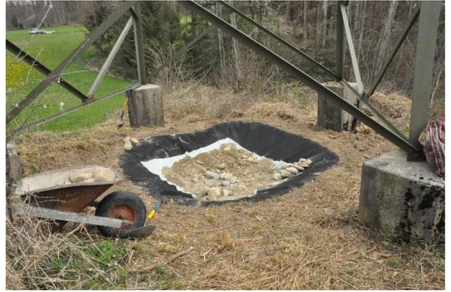
Abb. 4: Bau: Folie, Vlies und anschliessend Ausgestaltung mit Wandkies und Bollensteinen
