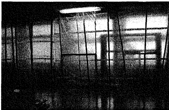
Schutzkonstruktion Fensterfront Innenraum
