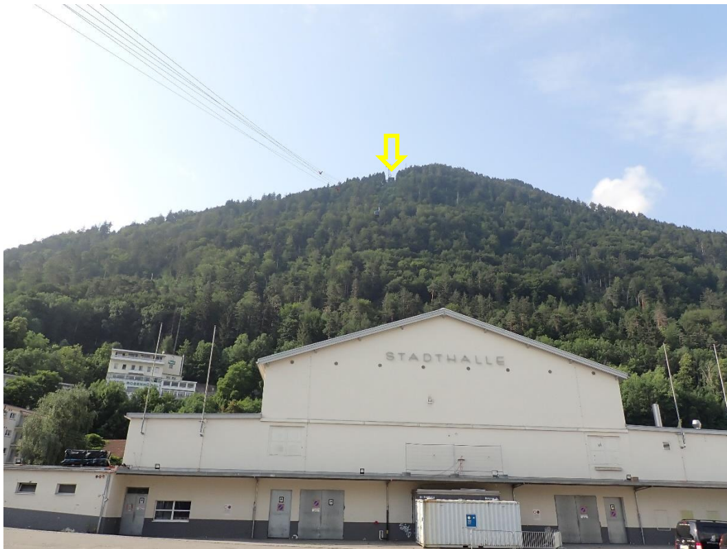
Abbildung 6-14: Abschnitt 1: Blick von der geplanten Talstation "Stadthalle Chur" (592.50 m.ü.M.) in Richtung der geplanten Mittelstation "Fülian" (1341.05. m.ü.M.). Ebenfalls auf dem Foto ersichtlich ist die bestehende Bergbahn und die Mittelstation Känzeli (gelber Pfeil), welche vollständig rückgebaut und durch einen Neubau ersetzt wird. Die Linienführung der geplante Bergseilbahn wird rechts der bestehenden Bergbahn verlaufen. Der Korridor der Seilbahn (Wald mit Niederhaltung) wird gemäss aktuellem Kenntnisstand ca. 16 m betragen.
