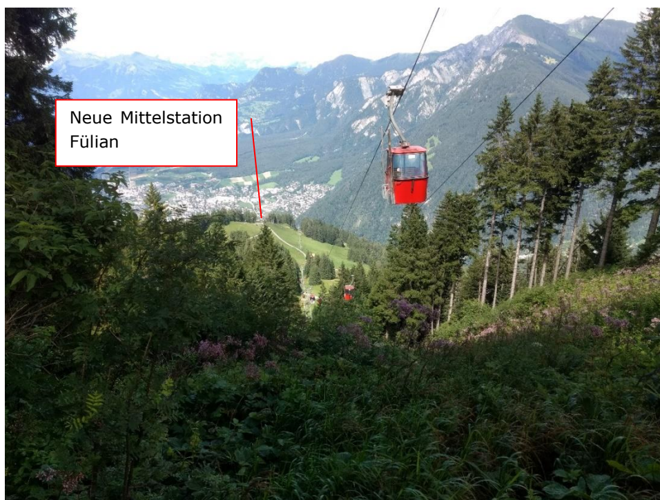
Abbildung 6-19: Abschnitt 2: Blick von der geplanten Bergstation Brambrüesch (1595.20) m.ü.M. zur Mittelstation «Fülän» (1341.05 m.ü.M.). Ebenfalls im Foto ersichtlich ist die bestehende Bergbahn, welche rückgebaut wird.
