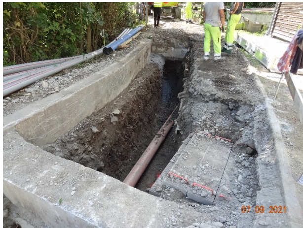
Verlegung Meteorabwasser
