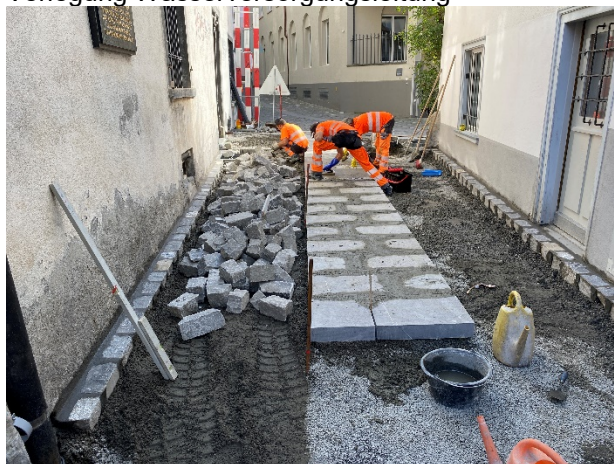
Versetzen Plattenbelag und Pflasterung
