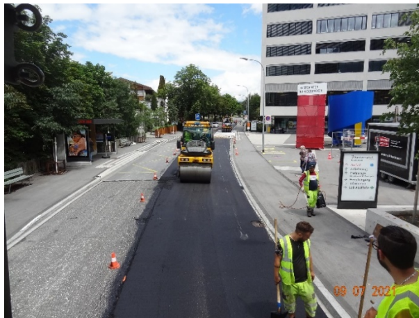
Z. Bsp. Deckbelag an der Loëstrasse
