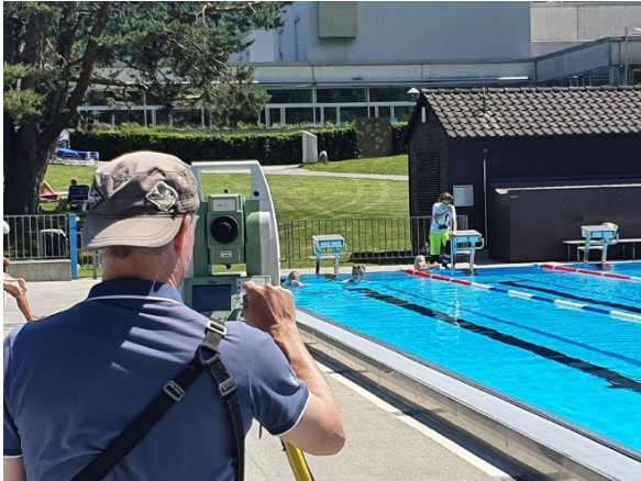
Vermessungsarbeiten für Sanierung 50m Aussenschwimmbecken, Obere Au
