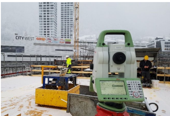
Bauvermessung, Neubau Kino City West
