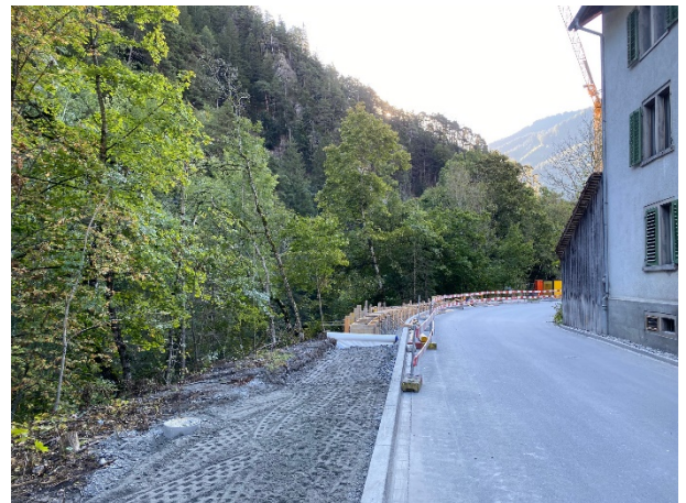
Bau Stützmauer mit Kordon
