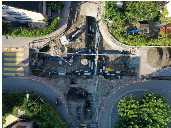
Werkleitungsbau Knoten Segantini- /Rheinstrasse
