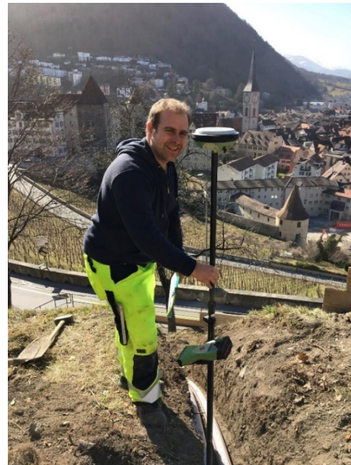
Aufnahme EW Leitung Arosastrasse/Kantonsschule
