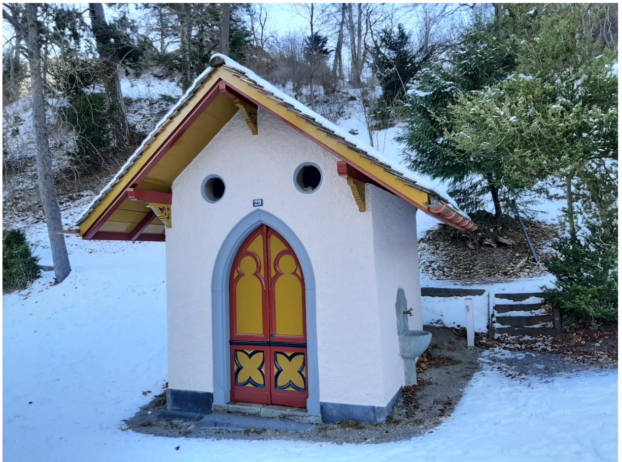
Rundum sanierte Brunnenstube im Rosenhügel
