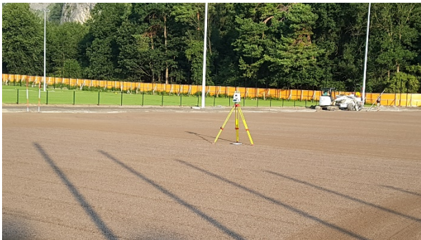
Ausführungskontrollen mit Flächenscan, Fussballfelder Obere Au
