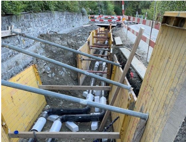
Verlegung Fernwärme
