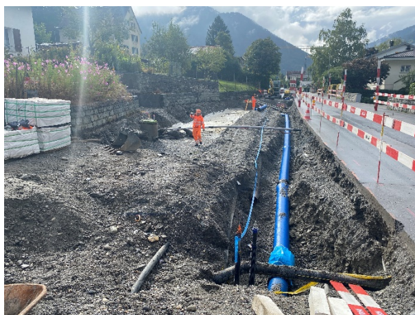
Umlegung Wasserleitung
