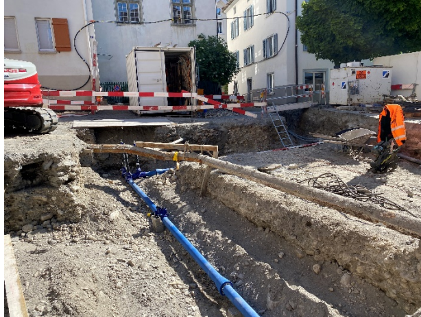
Verlegung Wasserversorgungsleitung
