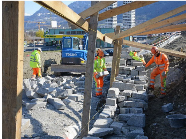
Erstellung neue Trockenmauer Kalkofenweg
