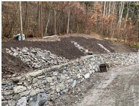
Neue Trockensteinmauer mit Steinhaufen für Kriechtiere
