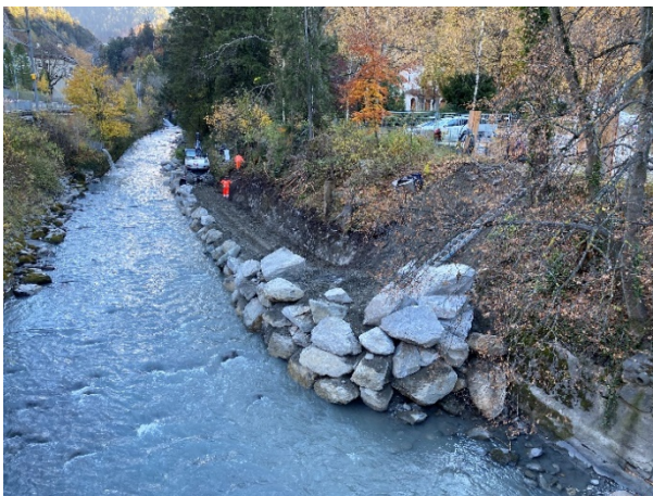
Arbeiten an der Wuhrmauer
