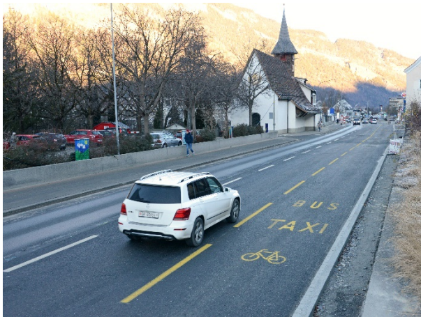
Die neue Bus- und Radspur
