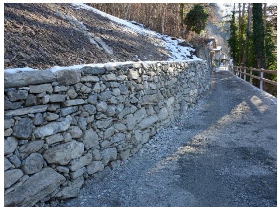
Trockensteinmauer und neue Absturzsicherung
