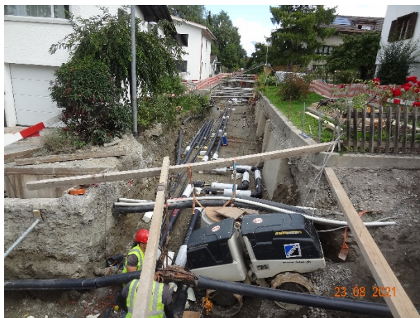
Fernwärmeerschliessung Strelaweg
