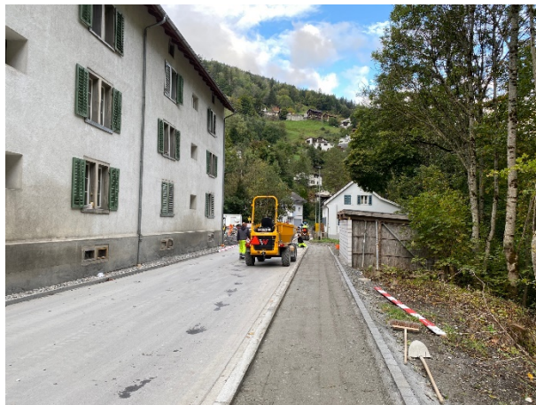
Planie für Belagseinbau im Trottoir
