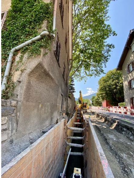
Abwasserleitung Höhe Haus zur Kante
