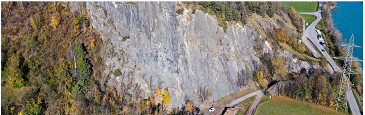
Südexponierte Wand im Klettergarten Haldenstein
