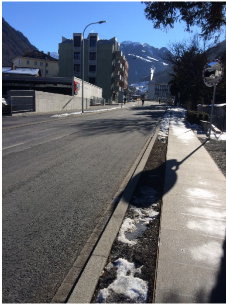
Sanierte Strasse mit Trottoir und behindertengerechten Natursteinplatten
