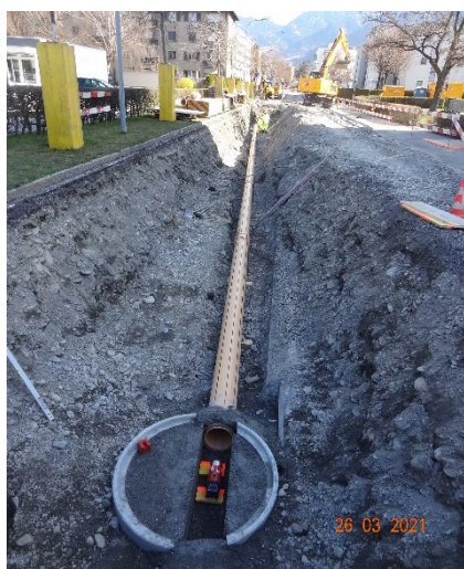
Neue Abwasserleitung
