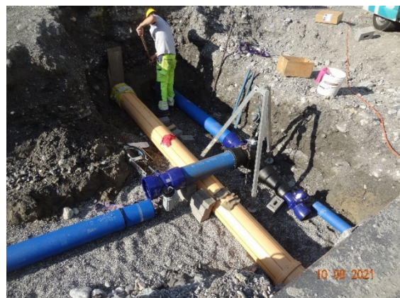
Einbau Wasserversorgung und Abwasser
