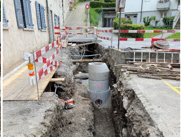
Neuer Abwasserschacht
