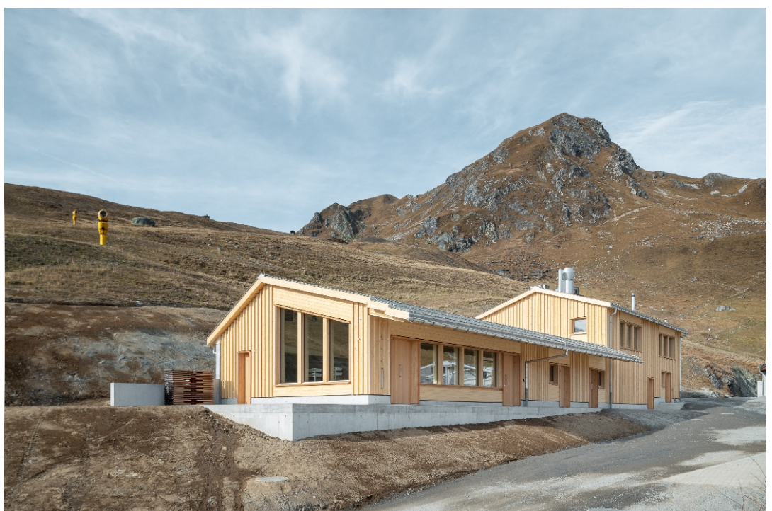
Neubau Selbstbedienungsrestaurant mit Alphütte Carmenna
