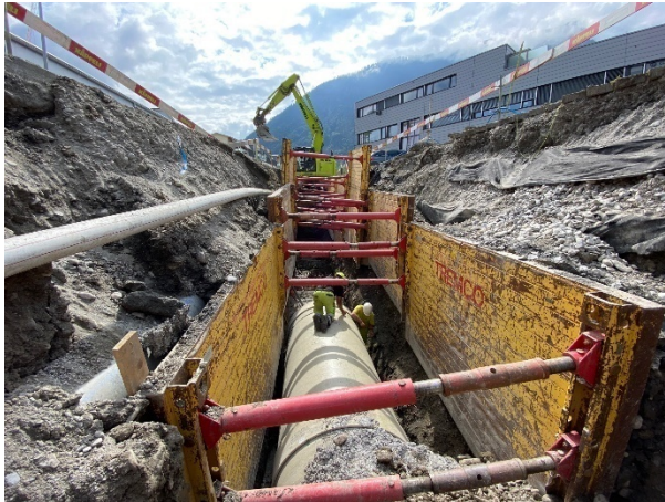
Anspruchsvoller Einbau der Leitungen DN 1'500
