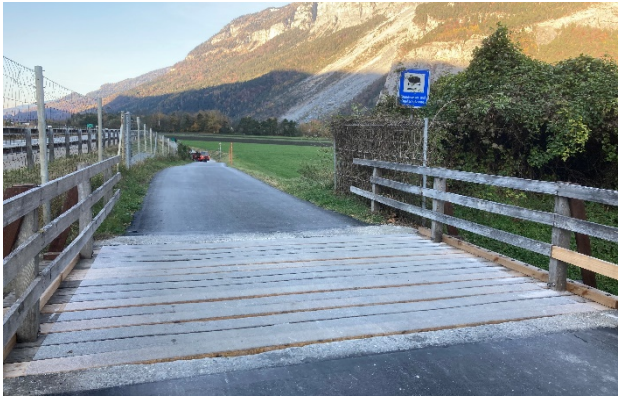
Antirutschbelag mit Zweikomponentenkleber, abgestreut mit Quarzsand
