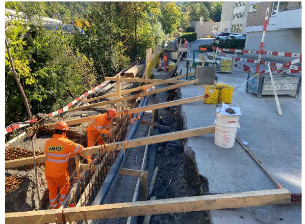
Bewehrung Stützkonstruktion
