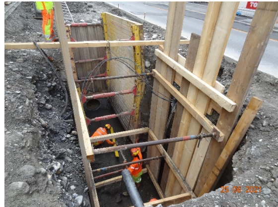
Grabenspriessung für die neue Abwasserleitung
