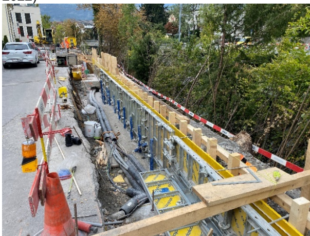
Schalung Stützkonstruktion
