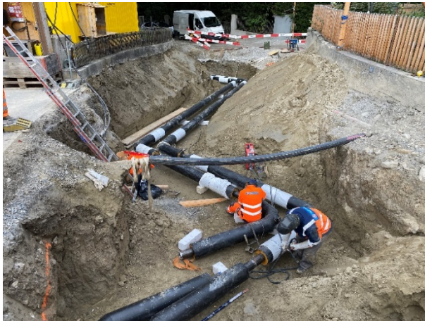
Verlegung Fernwärmeleitung
