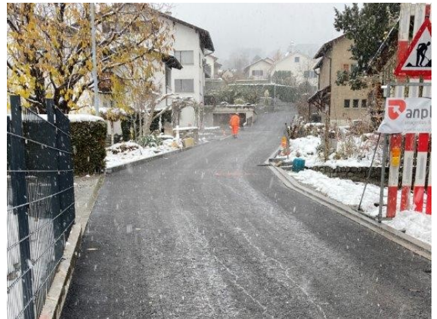
Belagseinbau Tragschicht
