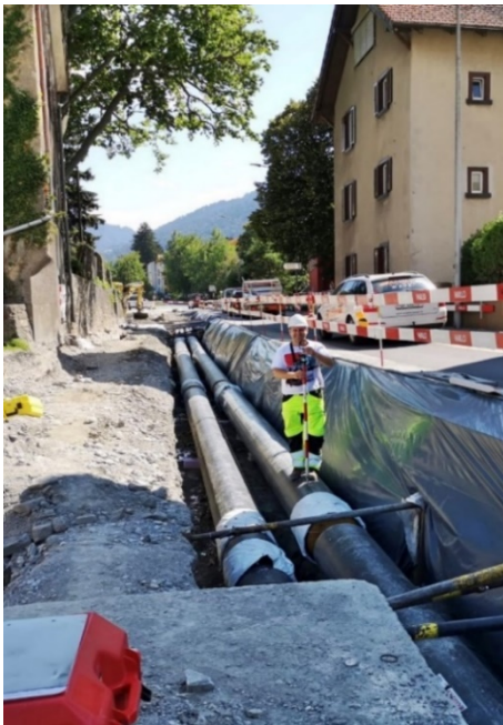
Aufnahme Wärmeleitung, Masanserstrasse
