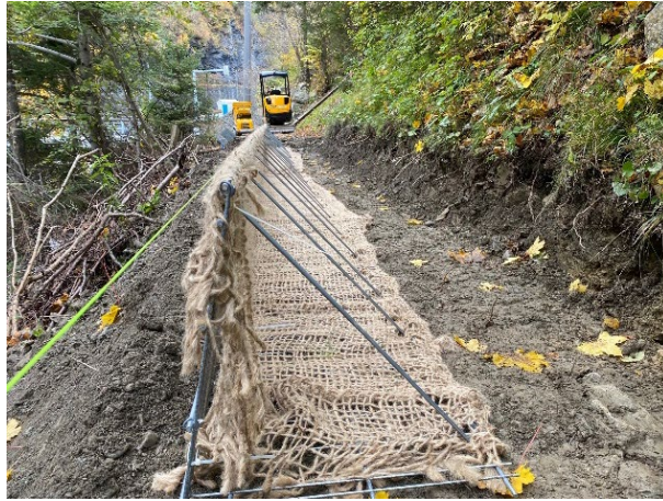
Bafix Elemente werden ausgerichtet
