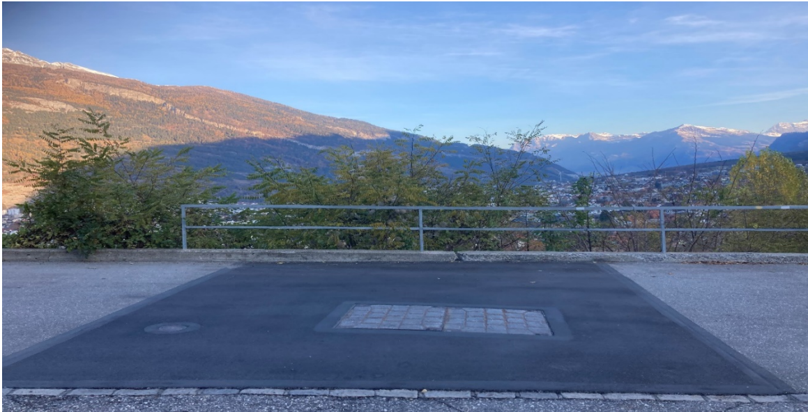
Sanierung Werkleitungsflicke
