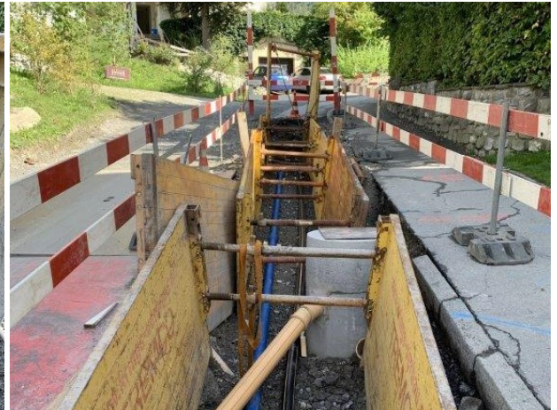
Verlegung Gas und Wasser
