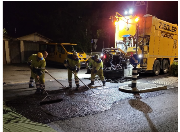
Einbau Kaltmicrobelag im Kreisel Ring-/Pulvermühlestrasse
