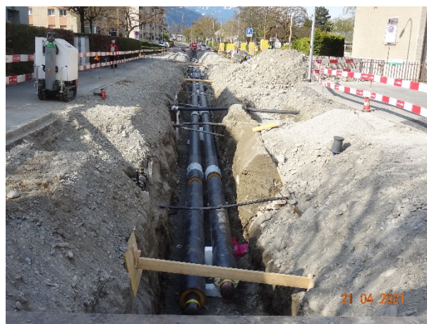
Verlegung Fernwärme
