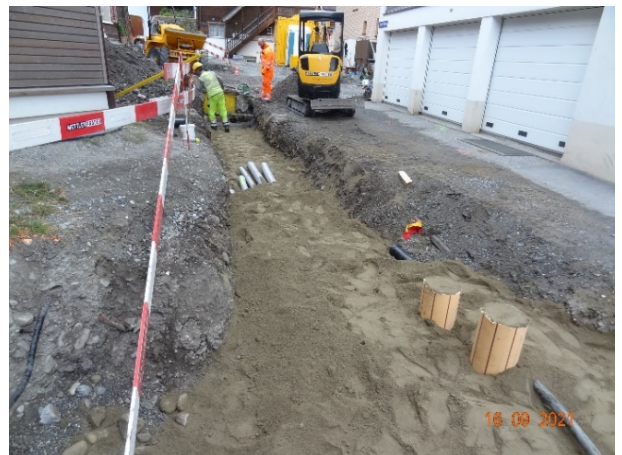
Umhüllung Werkleitungen
