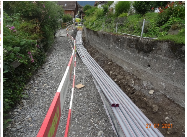
Verlegung EW-Rohrblock
