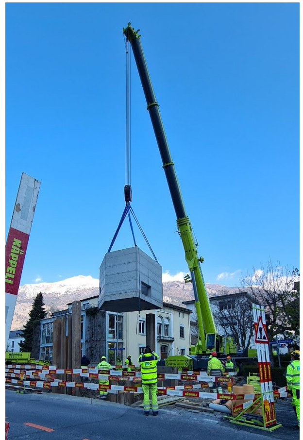
Versetzen vorproduzierter Abwasserschacht
