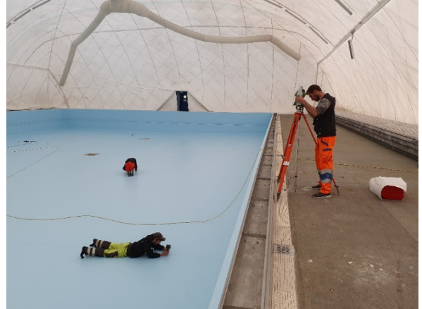
Vermessungsarbeiten für Sanierung 50m Aussenschwimmbecken, Obere Au
