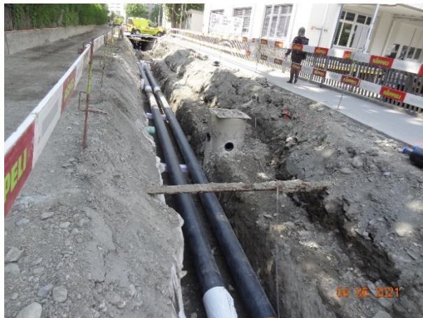
Verlegung der neuen Fernwärmeleitung
