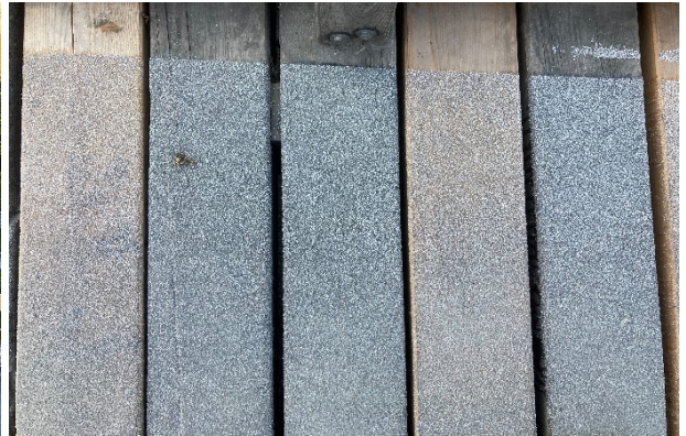
Antirutschbelag mit Zweikomponentenkleber, abgestreut mit Quarzsand
