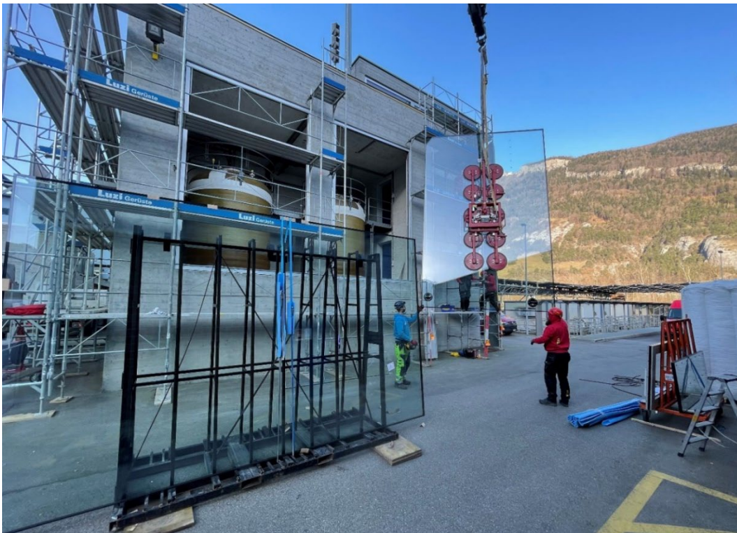
Silogebäude, Einbau neue Glasfassade mit deutlich besserer Wärmedämmung
