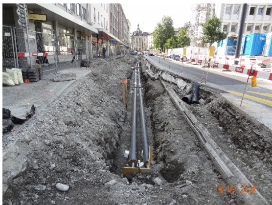
Neu verlegte Fernwärmeleitung
