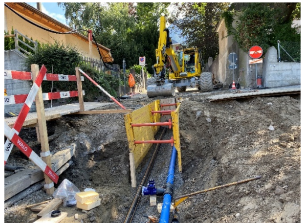
Erneuerung Gas- und Wasserleitung
