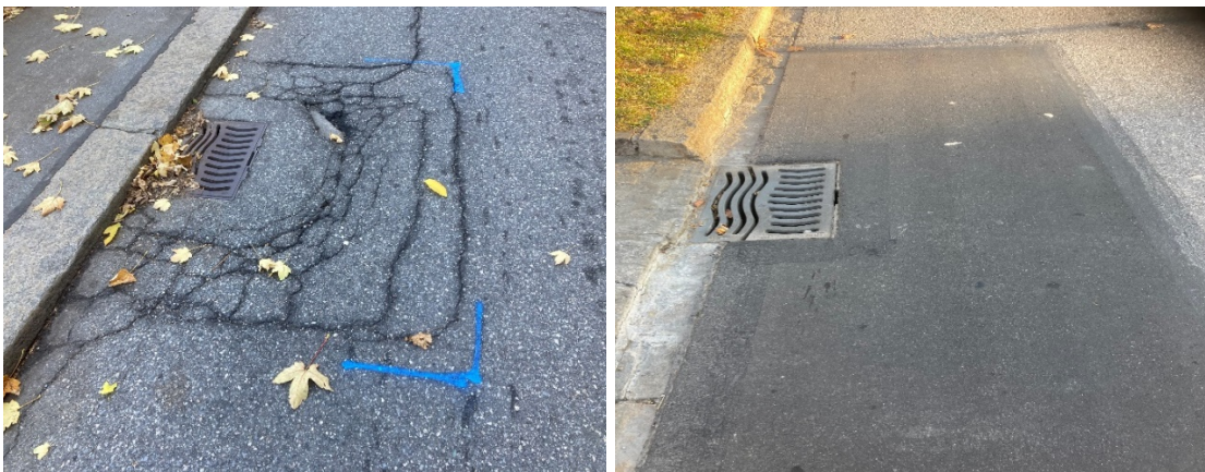
Schachtabdeckungen vor und nach der Sanierung
