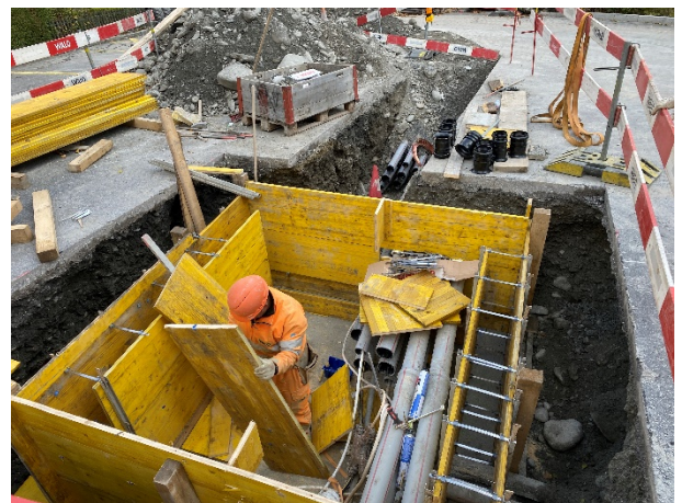
Schalung EW Schacht
