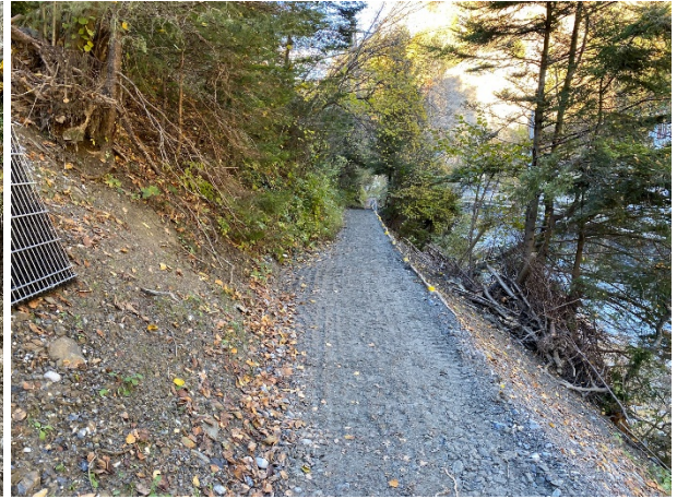
Fundationsschicht eingebaut
