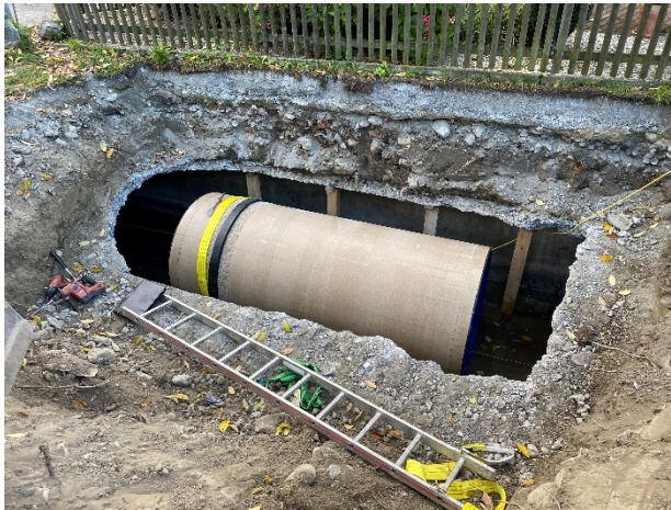
Rohrabladestelle für Rohreinzug
