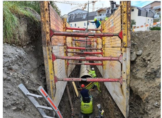
Arbeiten unter erschwerten Bedingungen
