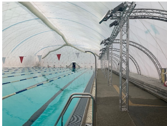
Neue Beleuchtung Traglufthalle
