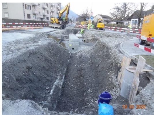
Rohplanie für Abwasserleitung
