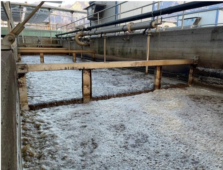
Hindernisfreier Wasserfluss durch neue Überfallkante und ohne Schaum nach ergriffenen Massnahmen
