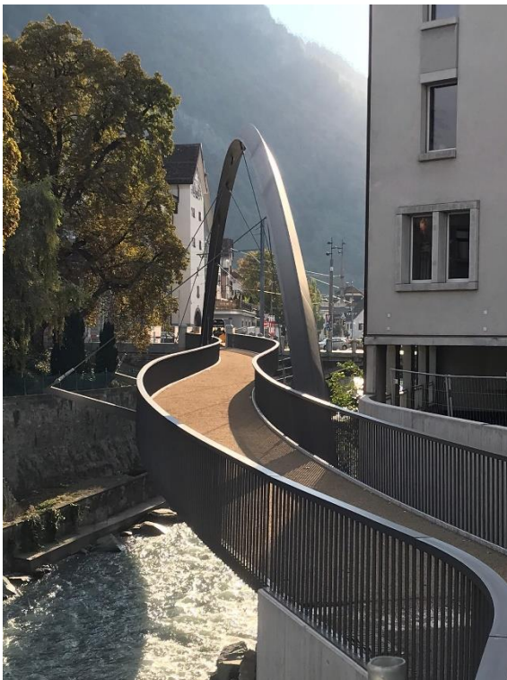
Die fertig erstellte Brücke bei Tag
