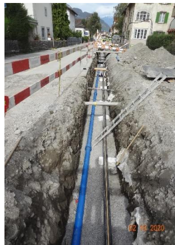
Verlegung Wasserleitung und EW
