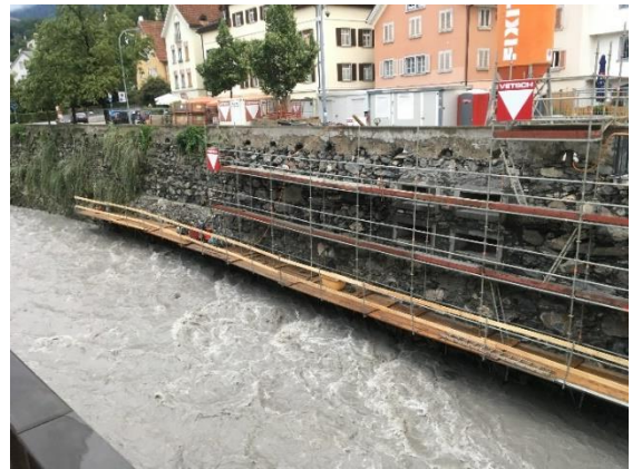
Wasserhaltung für Plattform mit Gerüst
