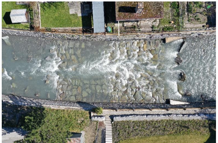
Fertiggestellte Blockrampe
