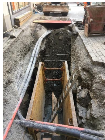
Baugrubensicherung Abwasserleitung
