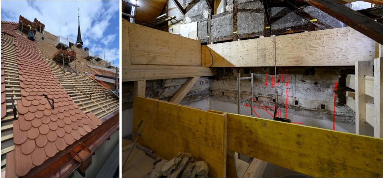
Rathaus Dachsanierung und Ausbau Dachgeschoss
