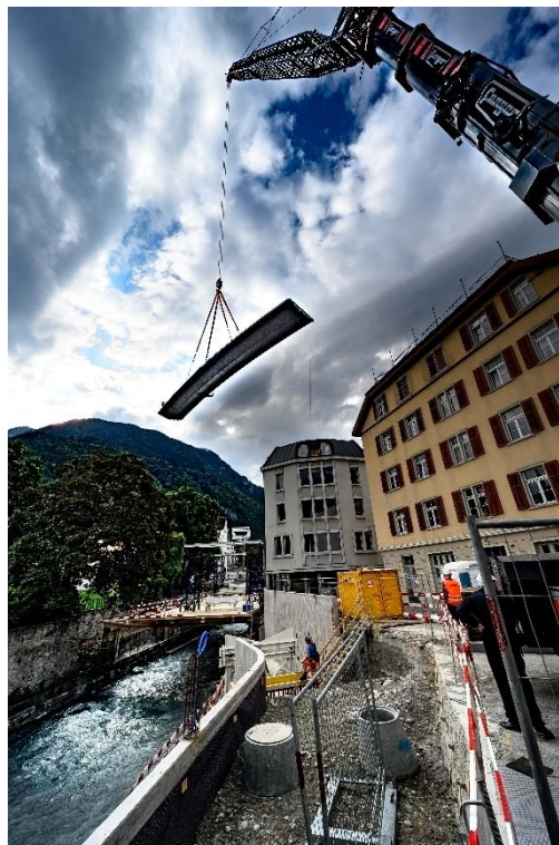
Einheben einer Fahrbahnplatte
