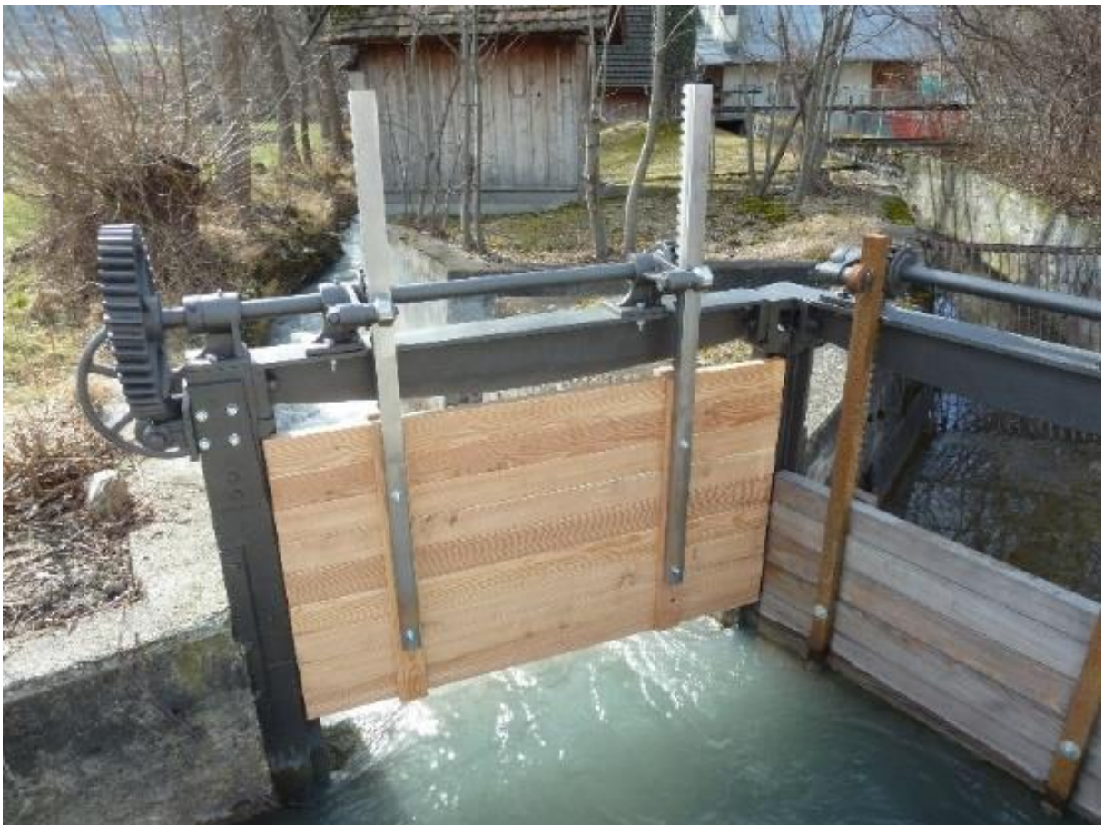
Sanierung Schieber Pulvermühle
