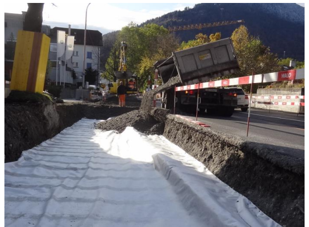
Einbau Foundationsschicht Masanserstrasse
