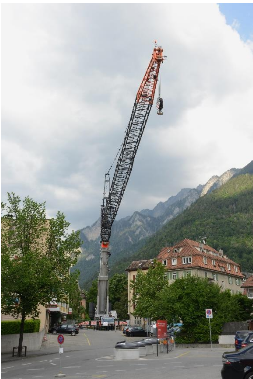
Der aufgebaute 500 t Pneukran
