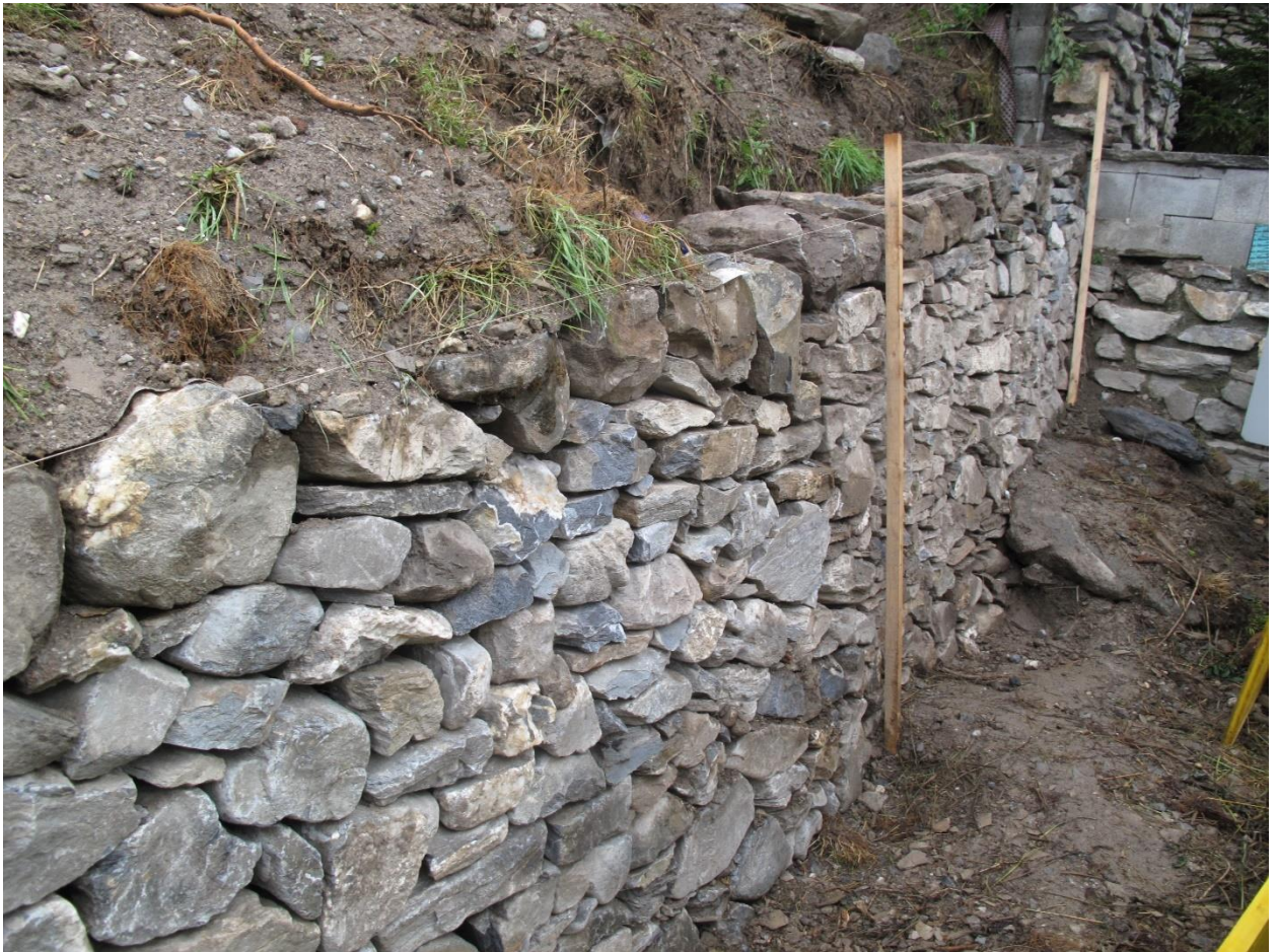
Neu erstellte Trockenmauer bei der Kirche Maladers
