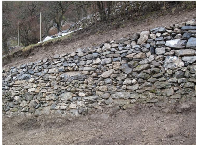
Sanierte Trockenmauer im Seidengut; Gehölze auf Mauerkrone wurden entfernt
