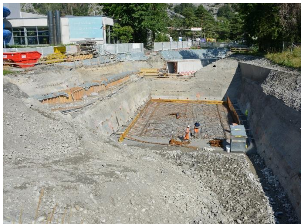
Erstellen der Bodenplatte
