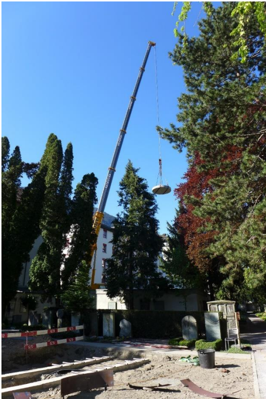
5.5 t Brunnen wurde mit Teleskop-Mobilkran in Friedhof gehoben
