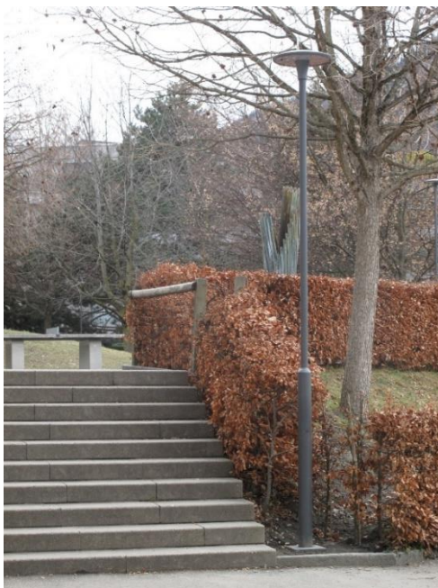
Besser Ausleuchtung der Treppenläufe im Schulhaus Montalin
