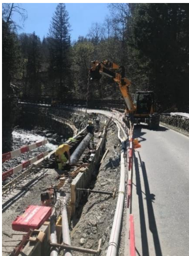
Neue Abwasserleitung integriert unter dem Kragtrottoir
