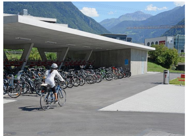
Die neue Veloabstellanlage mit Pump- und Reparaturstation sowie E-Bike Ladestation
