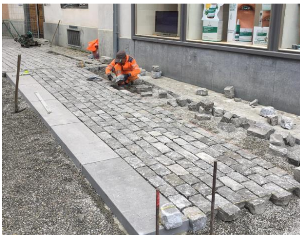
Neue Pflasterung mit Gubersteinen
