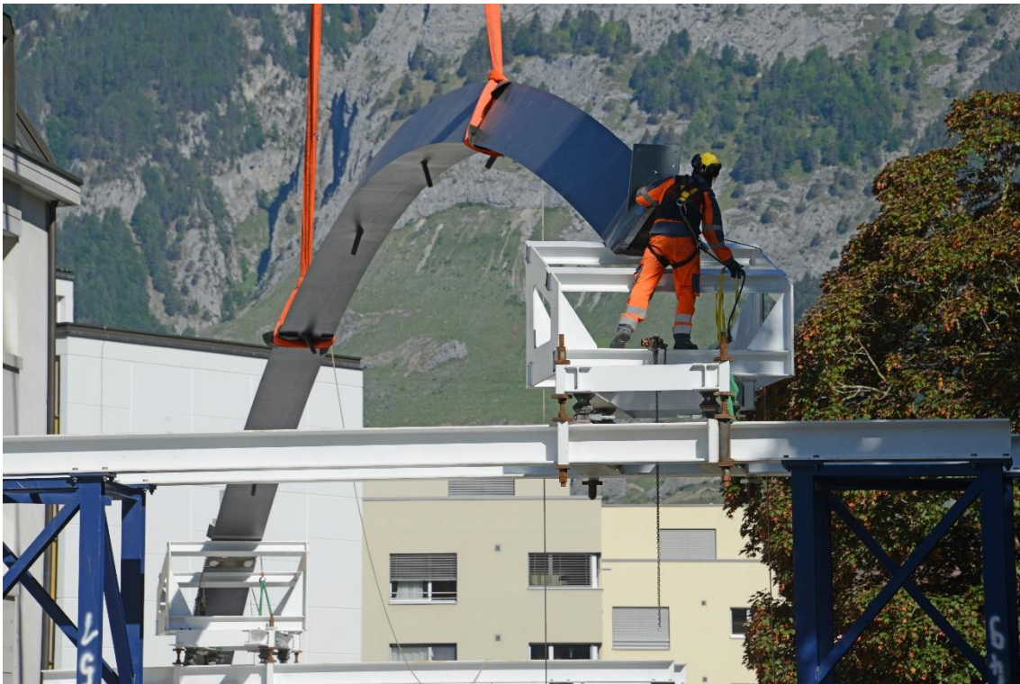
Einheben und platzieren der Bogenelemente
