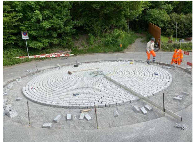
Wendeplatz Heckenweg mit Natursteinpflasterung
