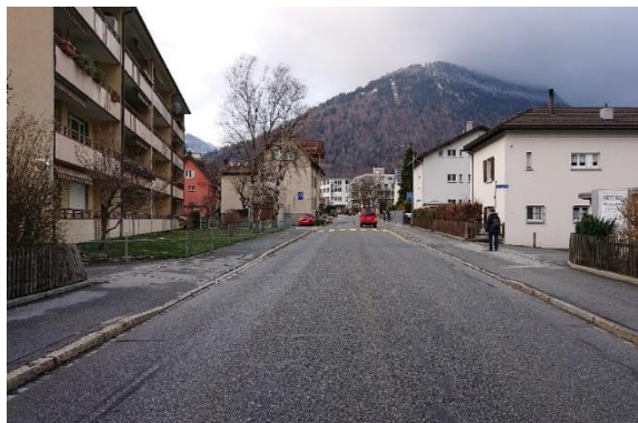
Zustand vor Baubeginn
