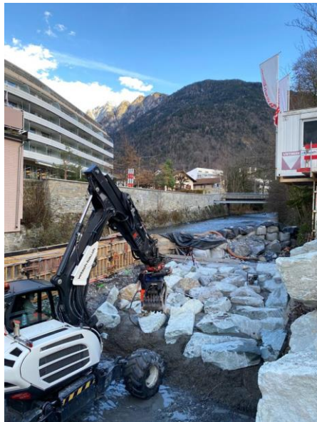
Bauarbeiten Blockrampe
