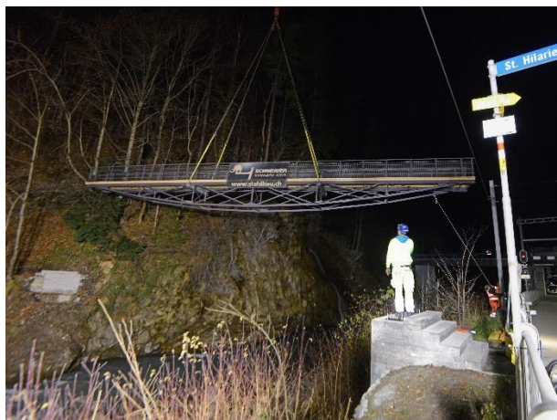
Einheben der Brücke während der Nacht
