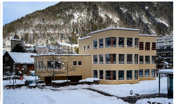
Neue Fassade beim Schulhaus Türligarten
