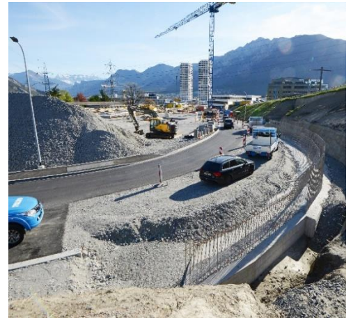
Erschliessung Trist, Anschlussbewehrung Stützmauer
