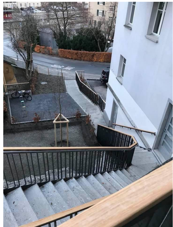
Treppenaufgang Hohenbühl mit Veloparkierung
