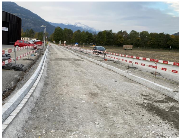
Versetzen der Randabschlüsse
