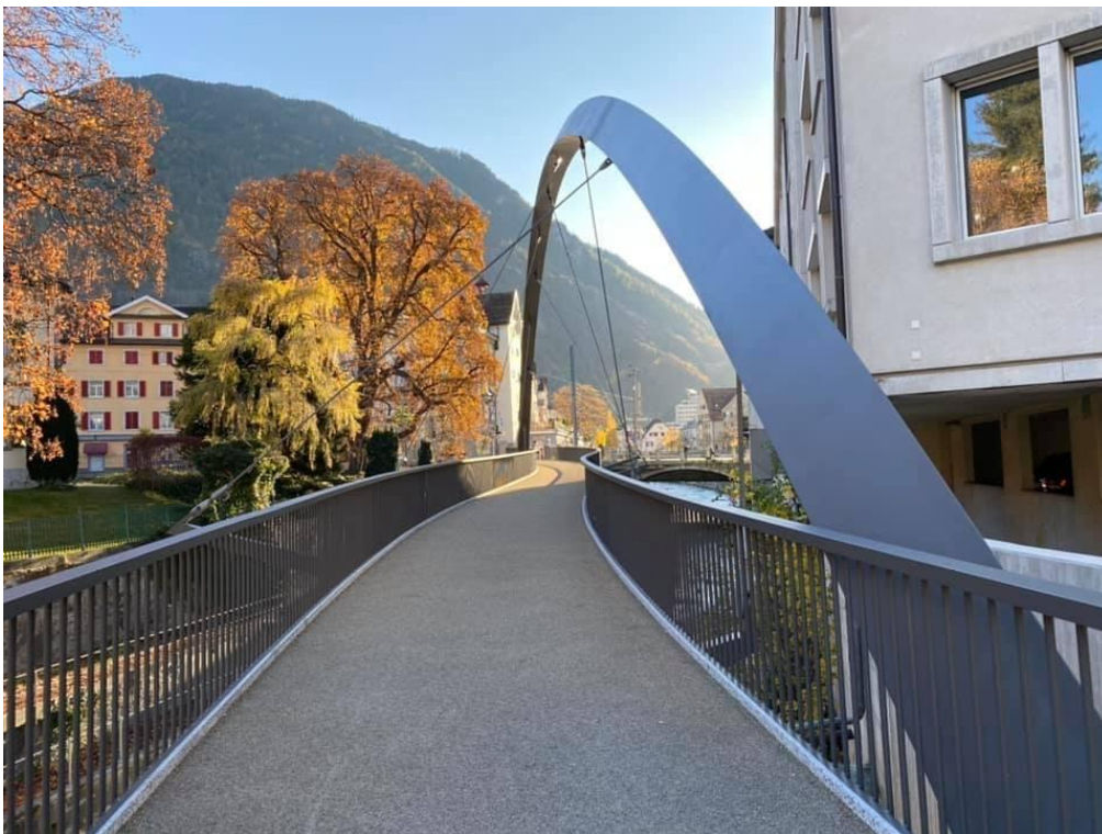
Die neu erstellte "Italienische Brücke"
