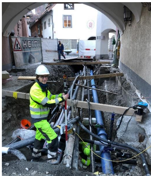
Aufnahme Werkleitungen St. Martinsplatz/Brotlaube
