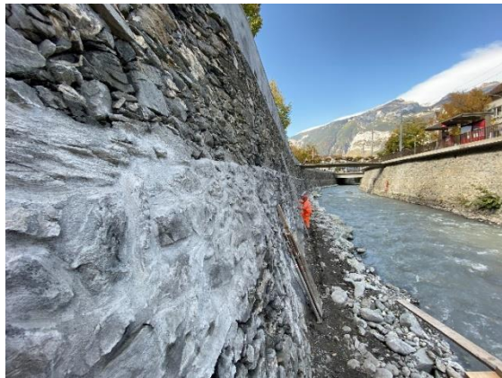
Im wasserführenden Bereich mittels Vollvermörtelung oder mit offenen Fugen.
