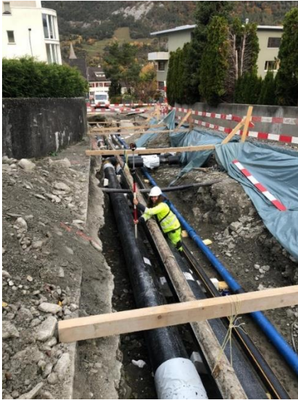
Aufnahme Werkleitungen Kirchgasse Masans
