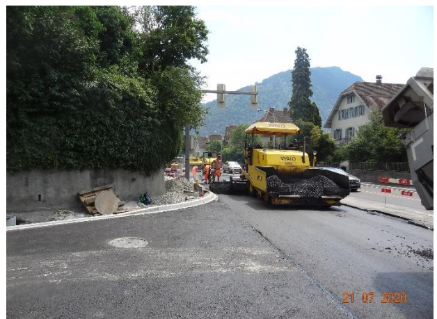
Belageinbau Binderschicht
