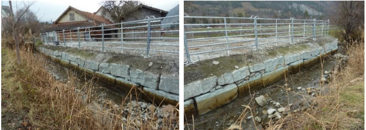
Renaturierte Mauer Dalpweg
