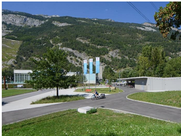
Aussenansicht des fertig erstellten Bauwerks
