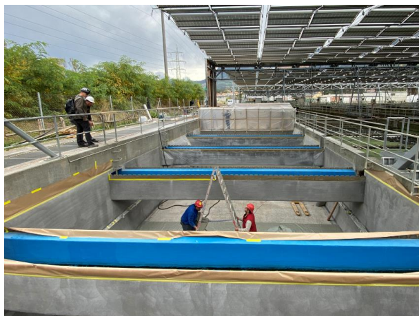
Nachklärbecken während der Sanierung
