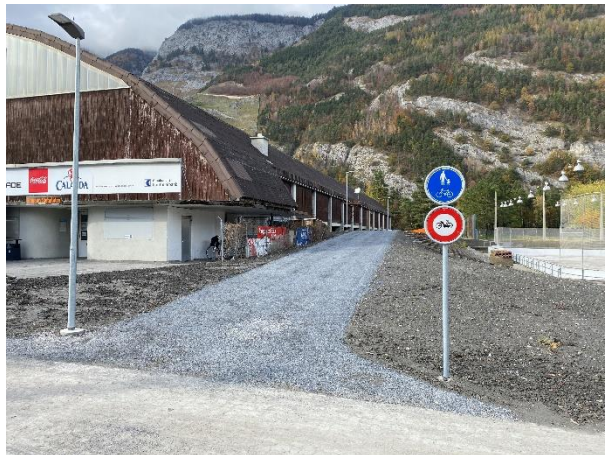
Zugang provisorische Fussgängerführung Hallenstadion
