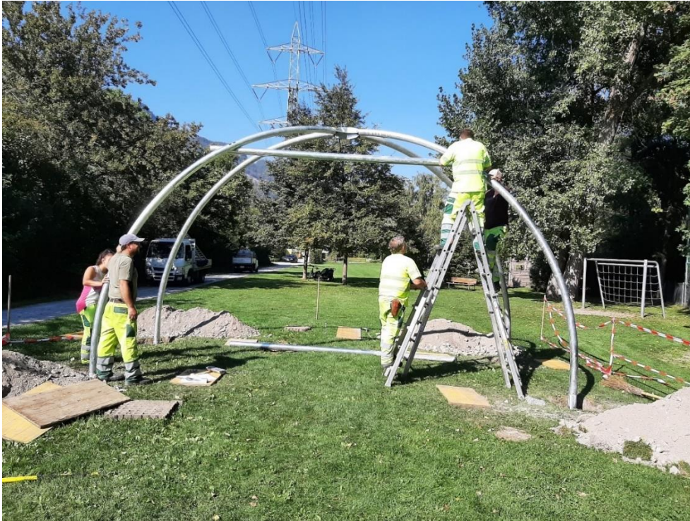
Mitarbeitende bei der Montage der "Kokoswelle" im Spielplatz Haldenstein
