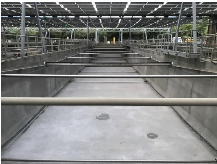
NKB nach erfolgter Sanierung sowie revidierten Balkenräumern und Förderketten
