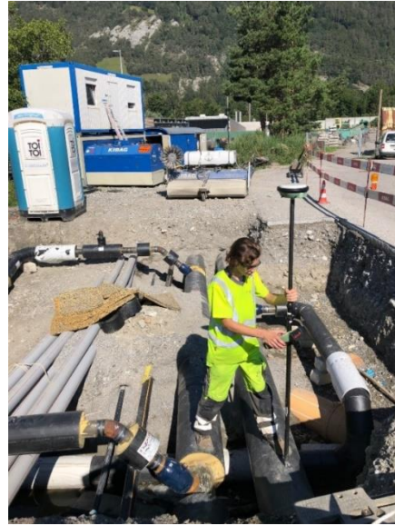
Aufn. Anergieleitung Anschluss ARA (Reitnauerweg)
