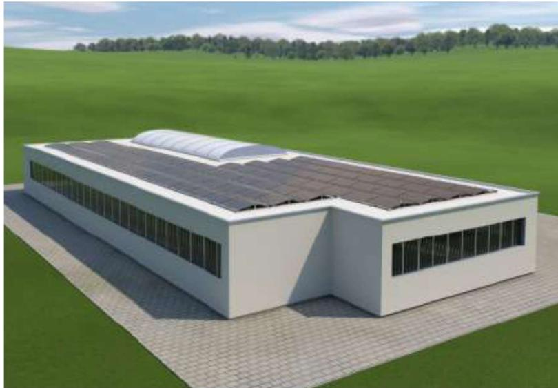
Die Montageart hat den Vorteil, dass keine Dachdurchdringung notwendig wird, die Anwendung ist auf allen Flachdächer bis 5 Grad möglich. (z.B. Folie, Kies, Bitumen etc.) Die Windlast kann je nach Standort individuell erhöht werden, dank der geringen Auflagefläche kommt die Konstruktion mit einer geringen Flächenlast von 30 – 50 kg/m<sup>2</sup> inklusive Unterkonstruktion und Module aus.
