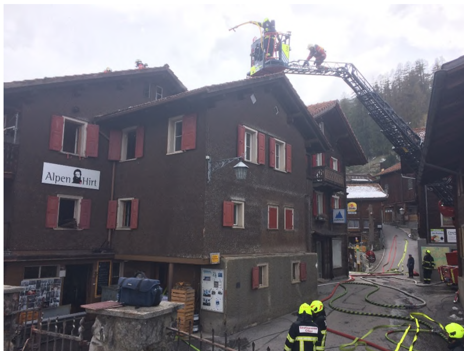
Hilfeleistung an die Feuerwehr Tschierschen. Einsatz der kompakten Autodrehleiter der Feuerwehr Chur im engen Dorfkern von Tschierschen
