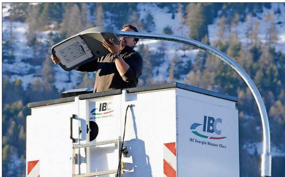
Die Umstellung von den Energie fressenden Natrium- und Quecksilberdampf-Hochdrucklampen auf sparsame LED-Technologie ist in den Strassen von Chur in vollem Gang.
