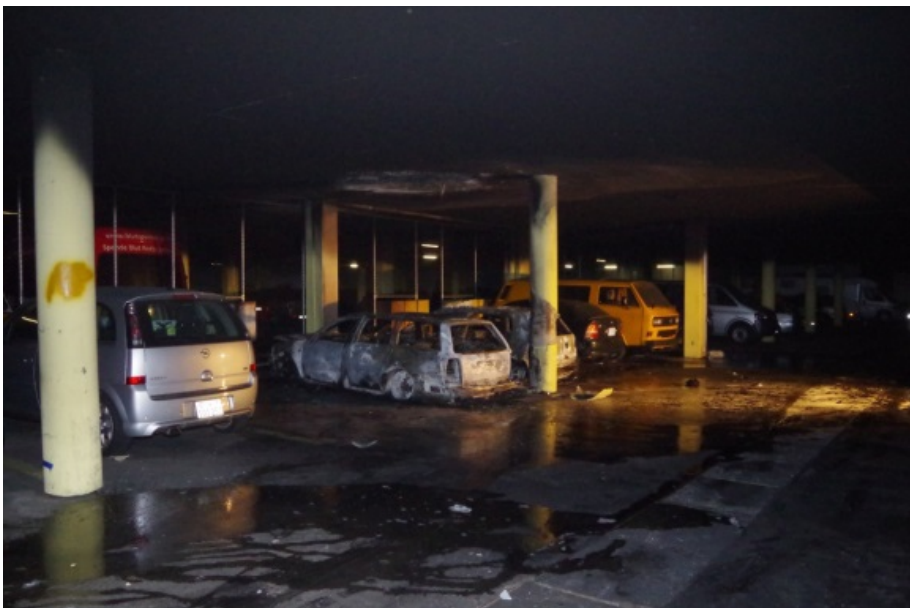
Brand in der Einstellhalle Belmont vom 17. März.
