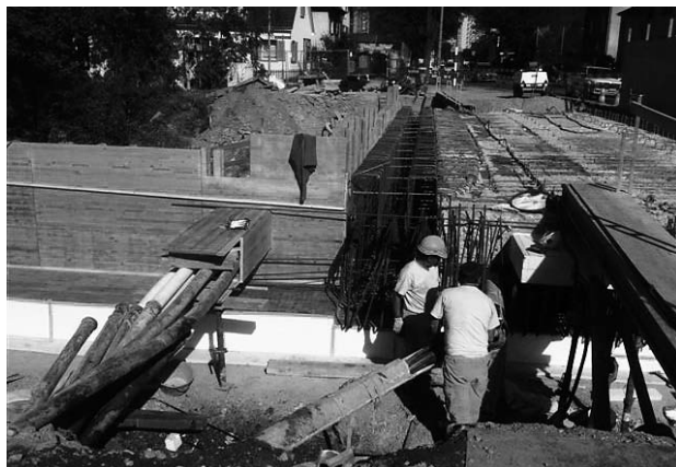
Alte Brückenkonstruktion freigelegt.
