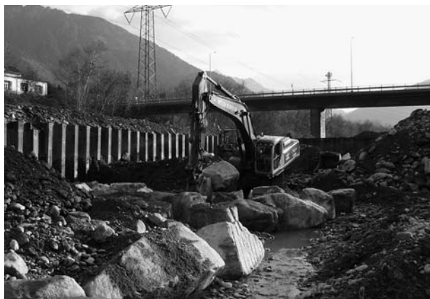
Versetzen der Blocksteine für Sohlenstabilisierung.
