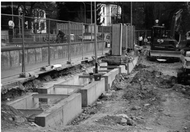
Spezielle Baumgruben wegen engen Platzverhältnissen.
