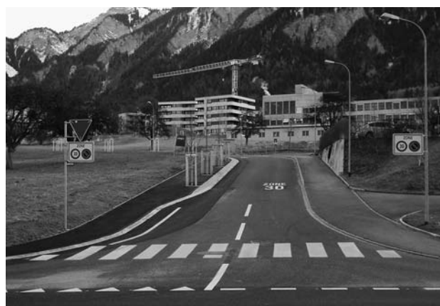
Blick über die neu erbaute Scalärastrasse, Verbindung Masanserstrasse - Cadonastrasse.
