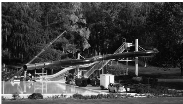
Röhrenrutschbahn Obere Au.
