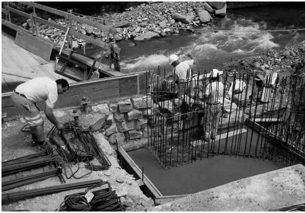
Erstellung des neuen Widerlagers.
