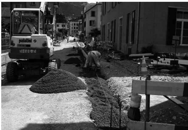
Versetzen der Randabschlüsse.
