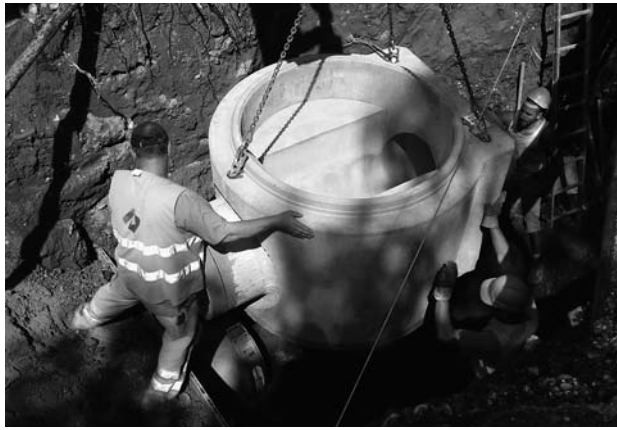
Versetzen eines vorfabrizierten Kanalisationsschachts.
