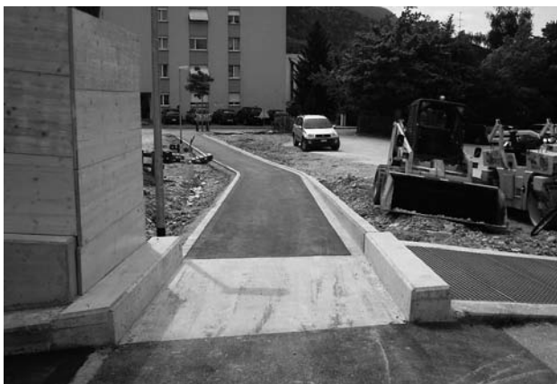
Neuer Fussweg mit Brücke über Mühlbach.
