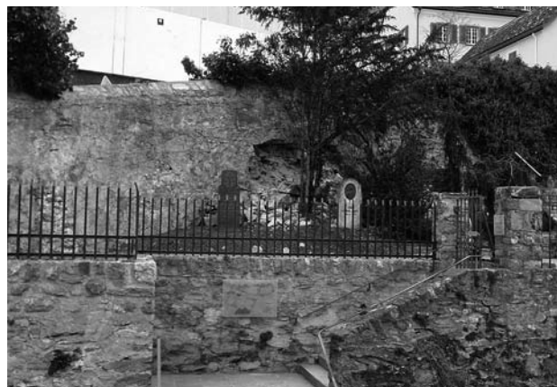
Mauerausbruch unter der Alten Schanfiggerstrasse.
