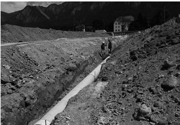
Die verlegte Kanalisation wird eingedeckt.
