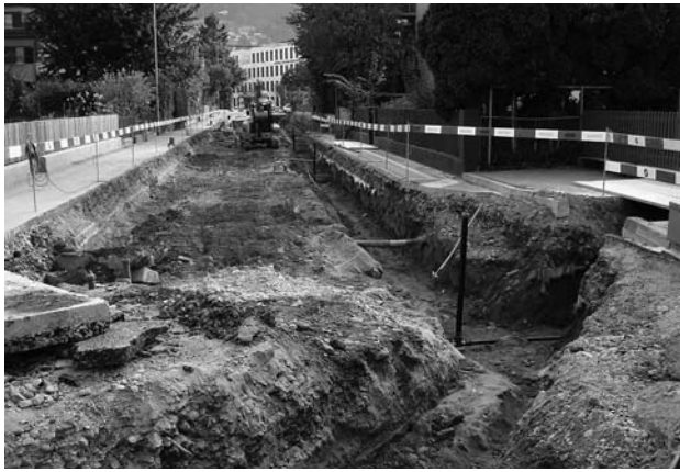
Leitungsraben für Wasser und EW.
