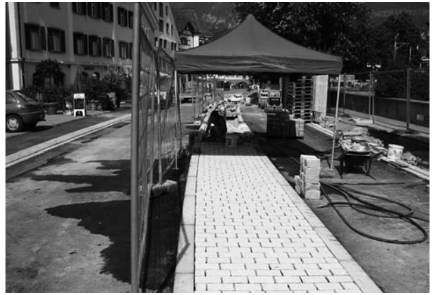
Pflasterstreifen beim Warteraum Carhalteplätze.
