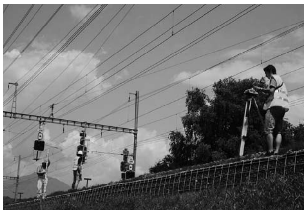
Nivellement/Setzungsmessungen Bahntrasse Schellenberg.
