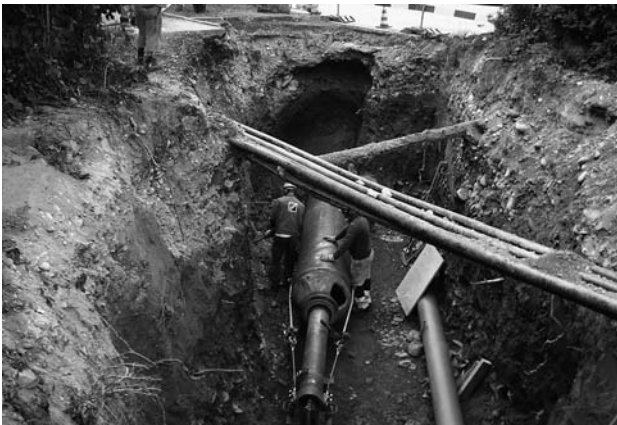
Schlagvortrieb unter der Ringstrasse für Kanalisationsleitung.
