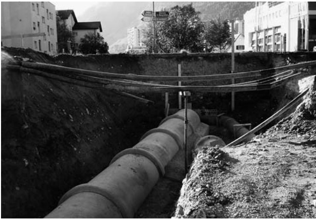
Verlegte Kanalisation vor dem Eindecken.
