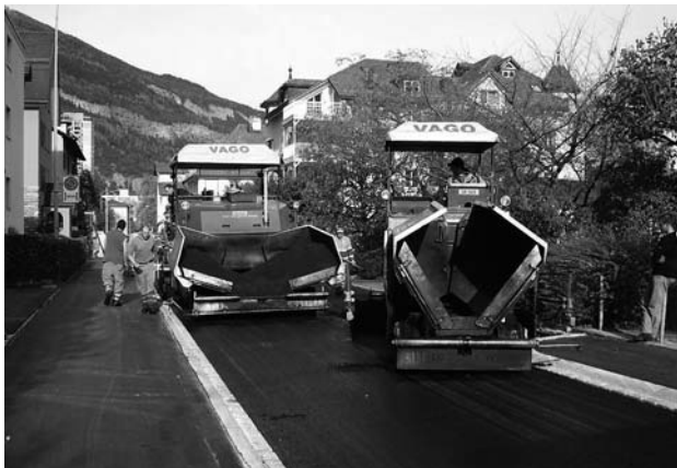
Fertigstellung mit Belagseinbau.
