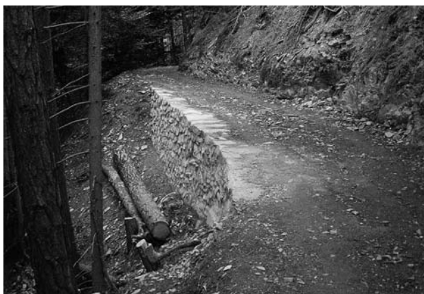
Instandstellung Kopfweg am Mittenberg.
