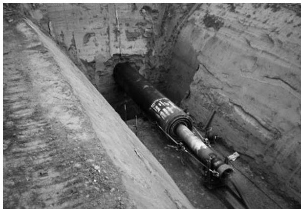
Schlagvortrieb unter den Gleisen der Rhb und SBB.
