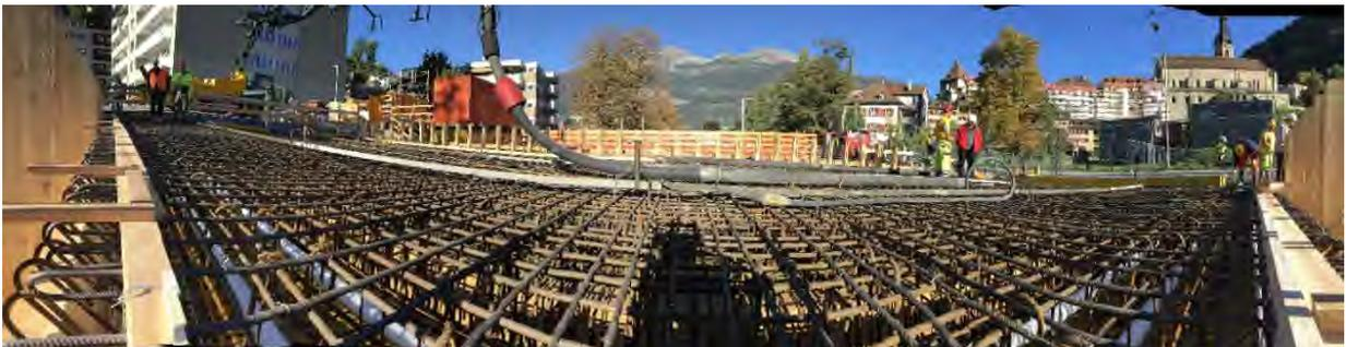
Start der Betonierarbeiten der neuen Brückenplatte
