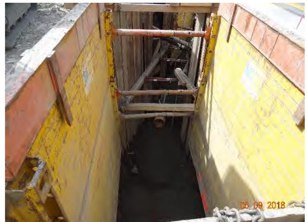
Grabensicherung für Abwasserleitungsbau
