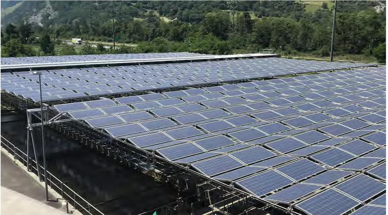
Solar-Faltdach-HORIZON über den Klärbecken der ARA Chur
