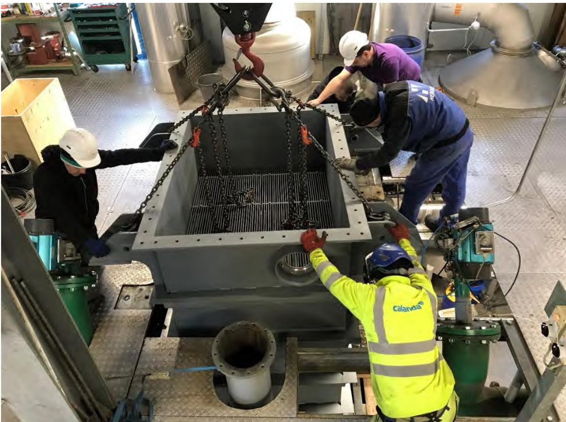
Millimeterarbeit beim Ein- und Ausbau des Rohrbündel-Wärmetauschers
