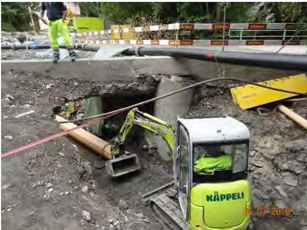
Einbau Abwasserleitung unter best. EW Trasse
