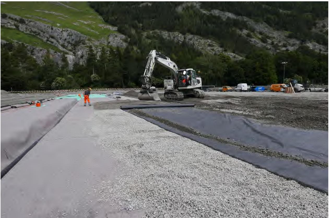
Legende: Unterbau mit Abdichtung und Drainage
