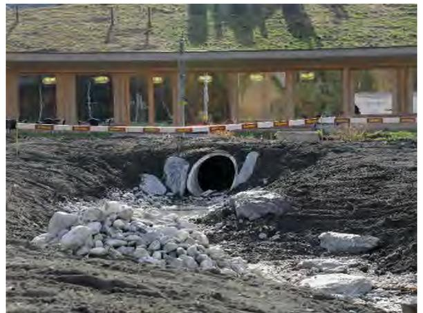
Auslauf kanalisierter Mühlbach
