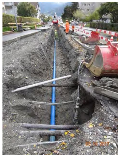
Verlegung der neuen Wasserversorgungsleitung der IBC Energie Wasser Chur
